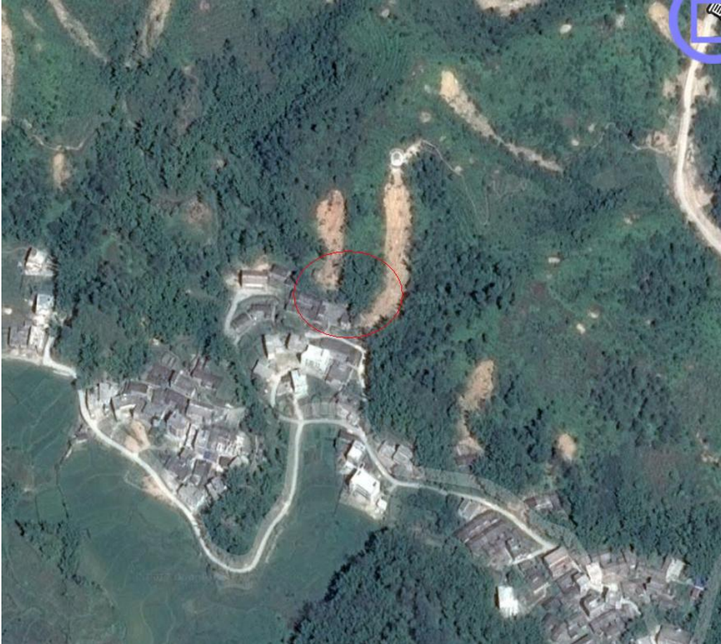
图1 信宜市北界镇长坡村富多组滑坡位置
